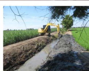
ทำทางระบายน้ำ
