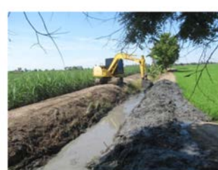
ทำทางระบายน้ำ
